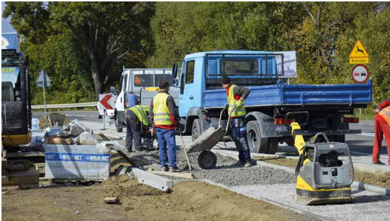
ZK w Uhercach Mineralnych. Osadzeni układają chodnik z kostki brukowej
