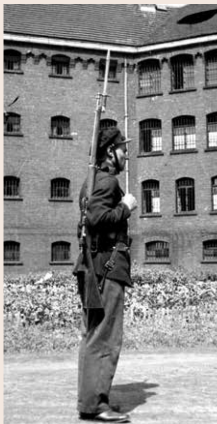
Katowice. Fragment budynku więziennego. Na pierwszym planie widoczny strażnik, trzymający karabin Carcano z nasadzonym bagnetem
