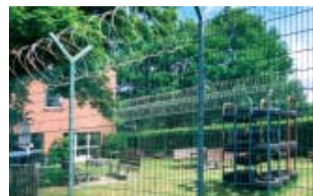
Budynek widzeń osadzonych w oddziale w Gros Hesepe i plac zabaw dla dzieci przychodzących w odwiedziny
